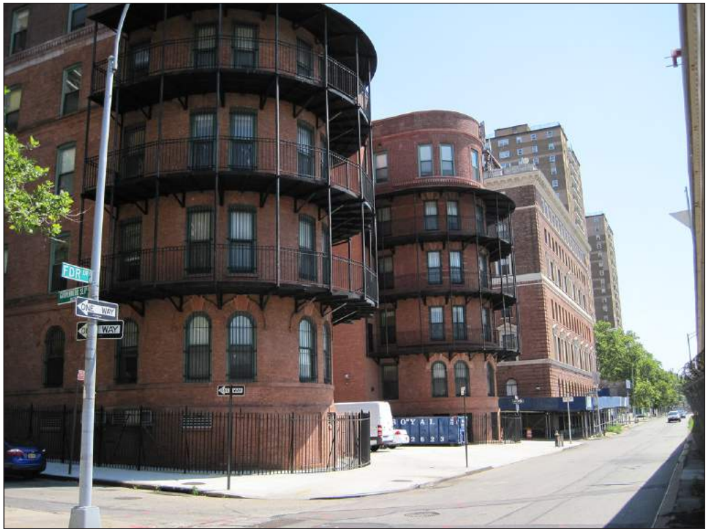
Gouverneur Hospital (#5). South Street façade 9
