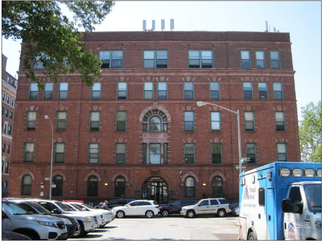
Gouverneur Hospital (#5). Water Street façade 8
